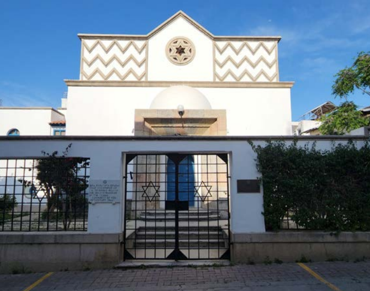
Εξωτερική άποψη της Συναγωγής της Κω. (Φωτογραφία Samuel D. Gruber, Αρχείο Ηλία Μεσσίνας).
